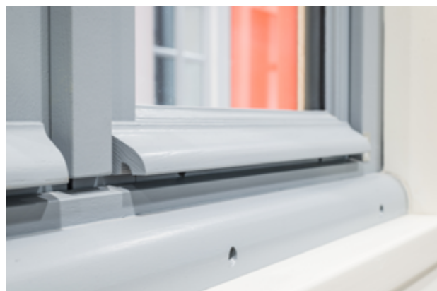
Jet d'eau à doucine plus esthétique et appui ABF spécifique pour la rénovation de patrimoine
