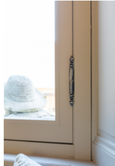
Ferrage traditionnel par paumelles entaillées
