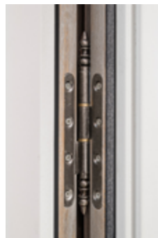
Fixation des volets sur paumelles tri-broches
