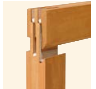
Le mode d'assemblage à double enfourchement collé
