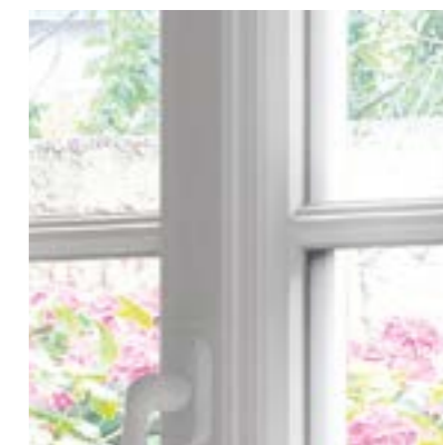
Battement central et parclose moulurée
